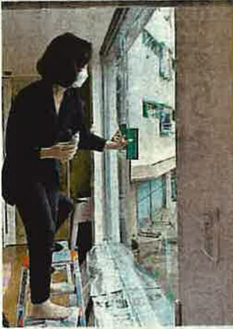
窓ガラスに有害物質を除去するコーティングを施工する高松市栗林町、みどり合同税理士法人グループの保育園
